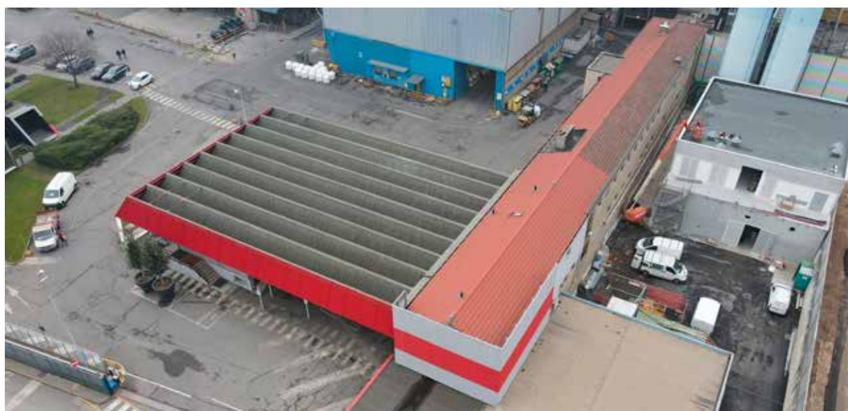
Lavori nel 2020 per la costruzione dell'impianto di recupero calore
