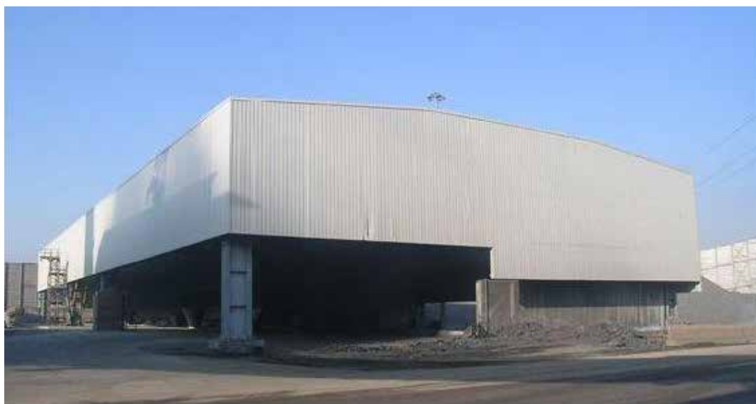
Capannone area scorie
