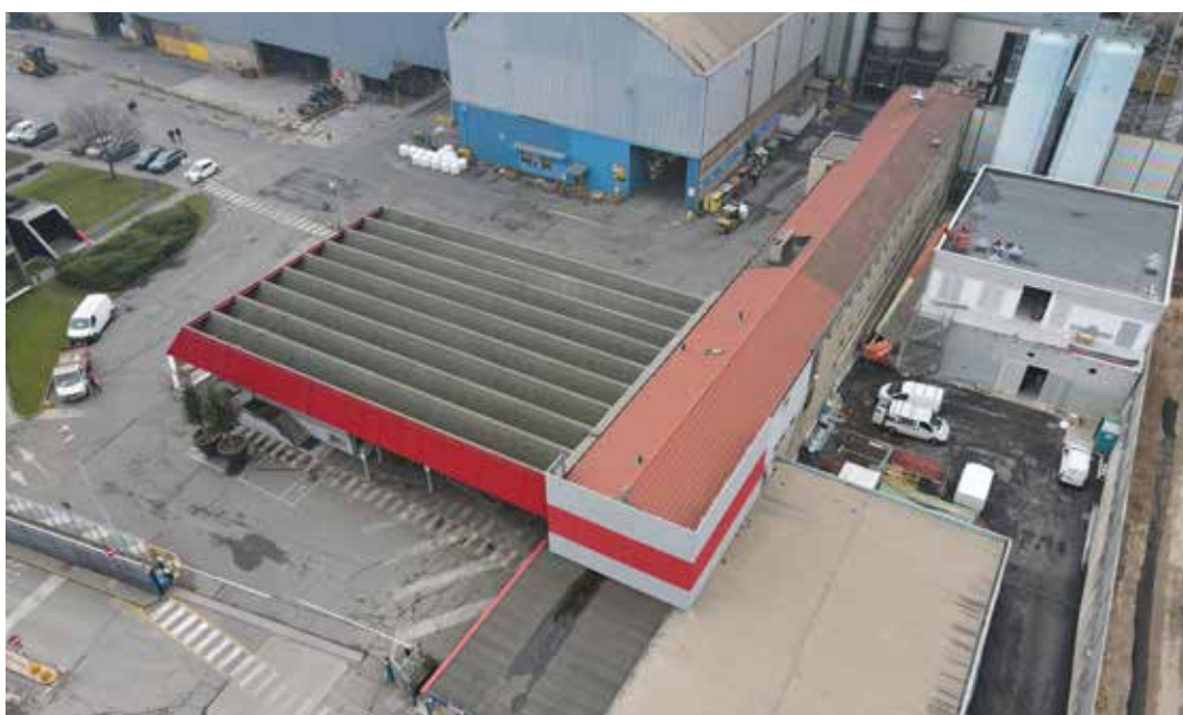
Lavori per la costruzione dell'impianto recupero calore
