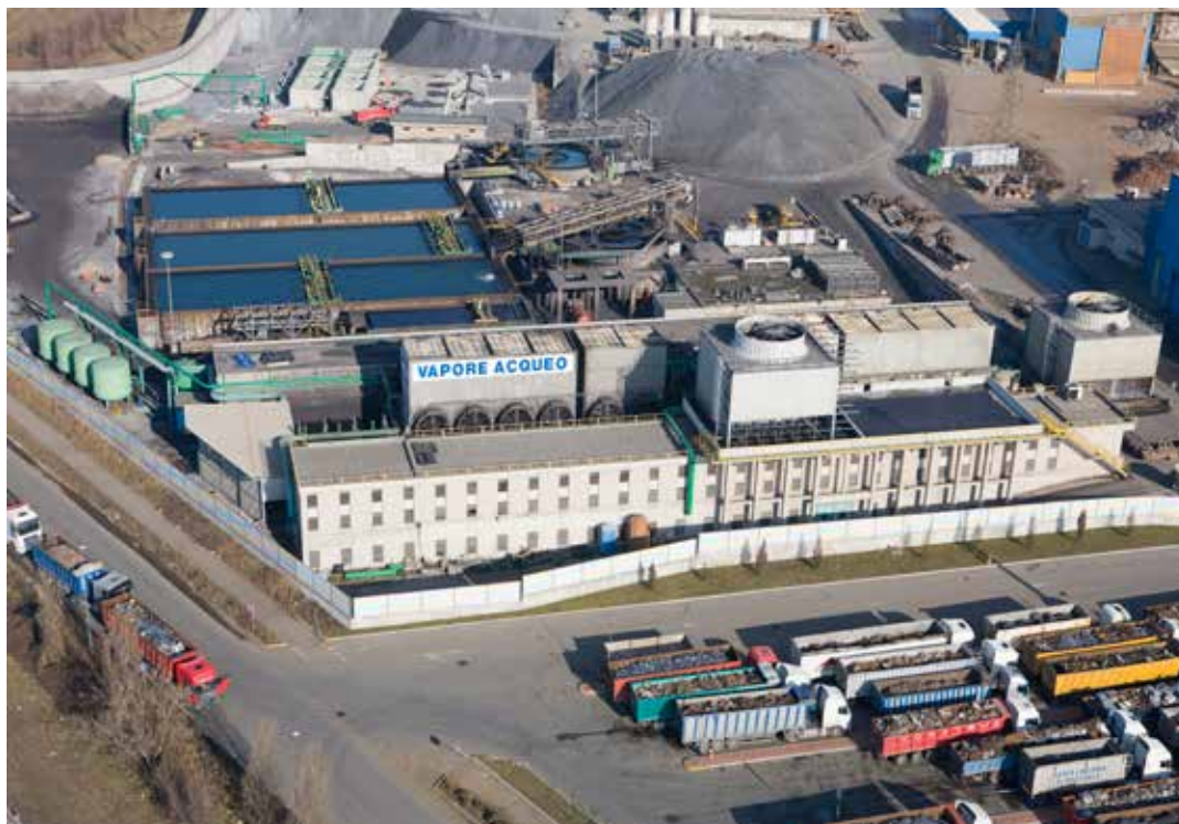
Torri evaporative e vasche di raccolta acque
