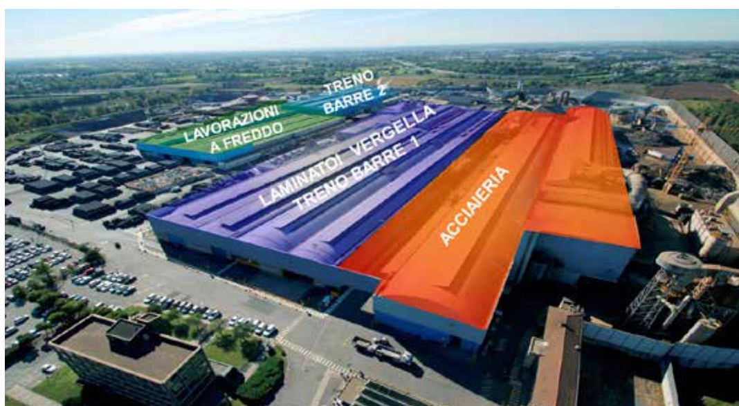
Vista di Alfa Acciai indicante la dislocazione delle 3 unità produttive e degli uffici
